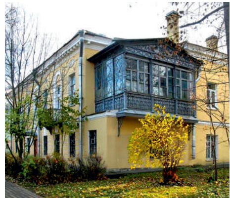
Дом на ул. Церковная, 12
